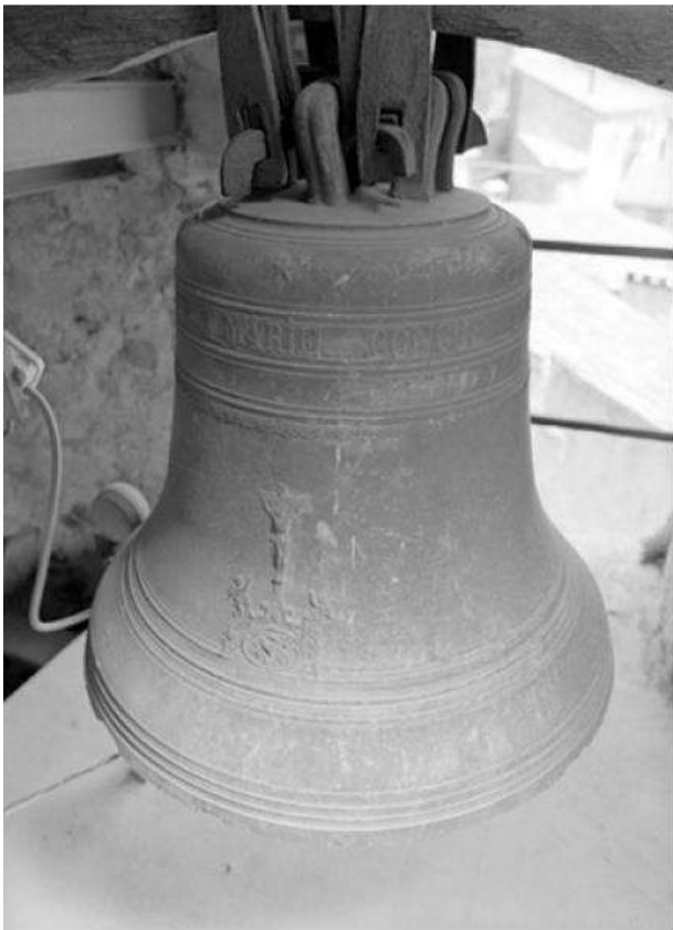
CLOCHE EXTERIEURE FIXEE SUR LE CHASSIS EN FER FORGE
